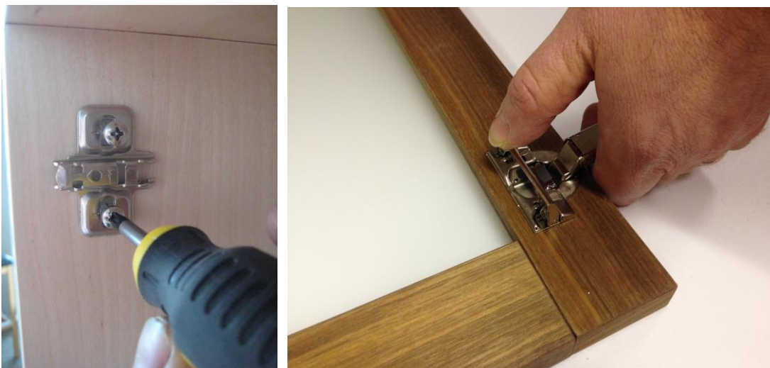
Bild vänster, beslag A monteras inne i skåpet – obs att den lilla pilen skall peka utåt! Bild höger, beslag B monteras på dörren. Med tummen "snäpper" man fast beslaget.
